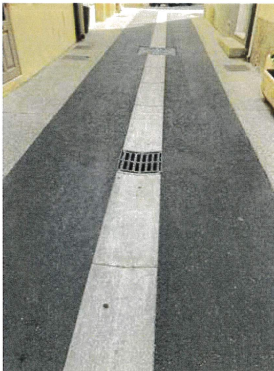
Revêtement des espaces circulables
