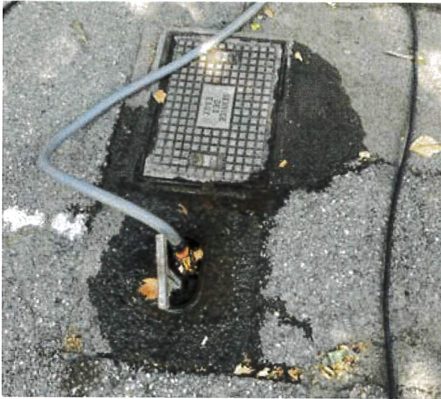
Branchement par les forains sur le réseau d'eau.
