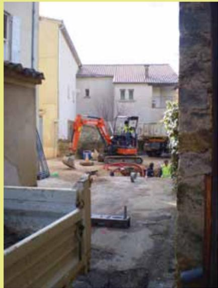
Ou encore la reconfiguration de la partie haute de la rue du Pont de l'Eze. A cet endroit, les anciens WC publics, fortement vétustes et non conformes notamment aux règles d'accessibilité ont été démolis pour mettre en place des conteneurs enterrés (permettant ainsi de supprimer le bac roulant régulièrement débordant) et créer la continuité du trottoir, inexistante à ce jour.
